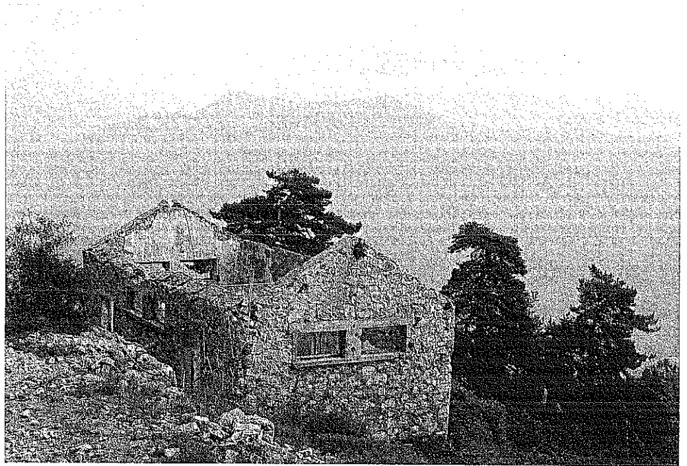
112. Esempio di architettura rurale lungo la valletta del rio Gerri
